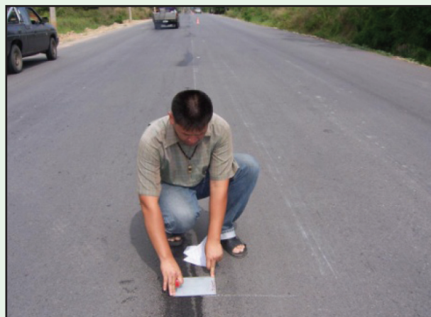
รูปที่ 7-11 แสดงการวางแผ่นเหล็กตามแนวที่จะทาสี
