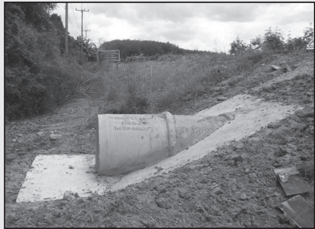
รูปที่ 5-41 หลังจากถอดแบบข้างแล้วให้ปรับดินโดยรอบให้เสมอผิวคอนกรีต
