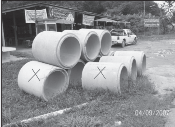
รูปที่ 5-4 ท่อที่ไม่ได้คุณภาพให้ทำเครื่องหมายไว้แล้วแจ้งผู้รับจ้างเปลี่ยนใหม่
