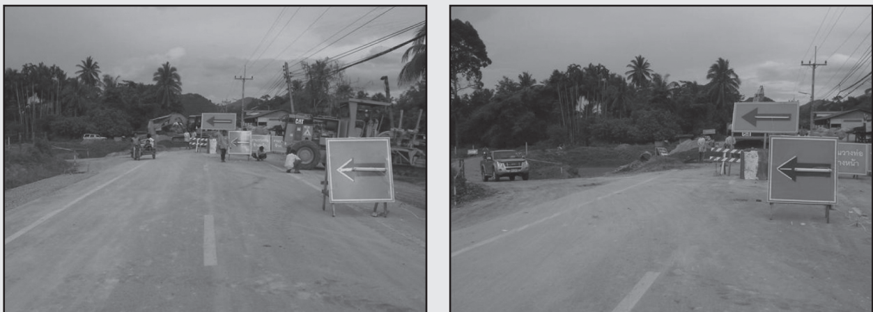
รูปที่ 5-19 แสดงการติดตั้งป้ายเตือนและไฟฟ้าแสงสว่างที่บริเวณก่อสร้าง
