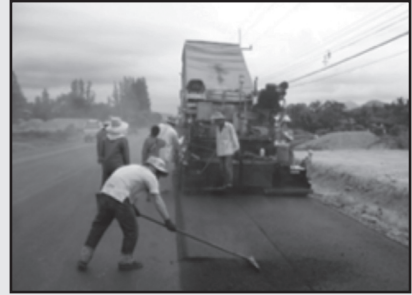
ควบคุมแนวการปู
