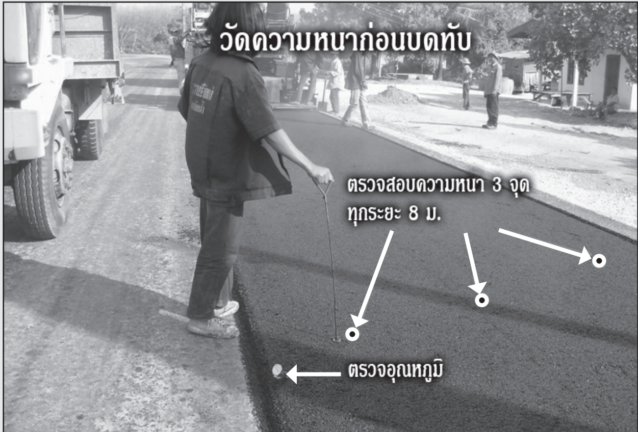
รูปที่ 6-31 การตรวจสอบความหนาและอุณหภูมิขณะปูแอสฟัลต์คอนกรีต
