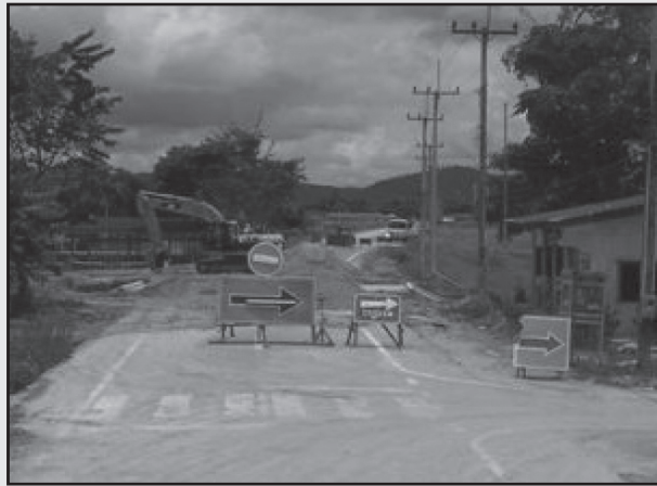
รูปที่ 5-20 การติดตั้งป้ายลูกศรบอกทิศทางการเบี่ยง
