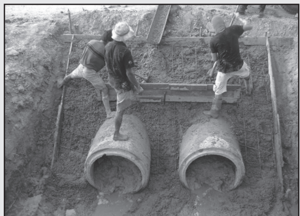
รูปที่ 5-38 การเสริมเหล็ก และการทดสอบกริดกำแพงปากท่อ
