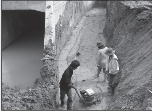
รูปที่ 5-32 การบดอัดข้างท่อเหลี่ยม
