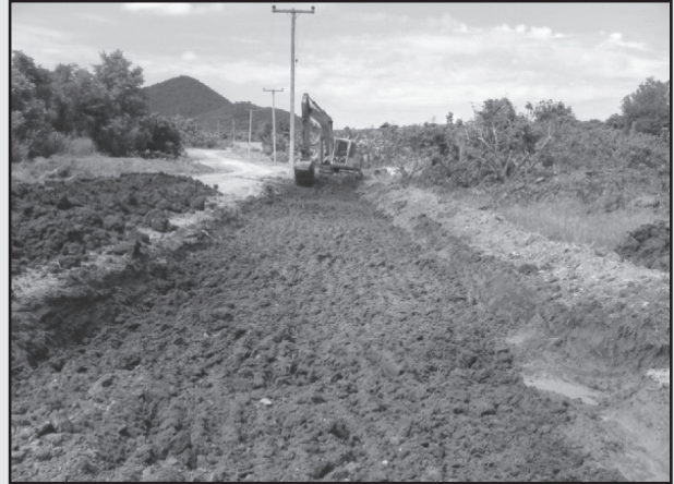
รูปที่ 5-9 ลักษณะดินที่ต้องปรับปรุงก่อนวางท่อ
