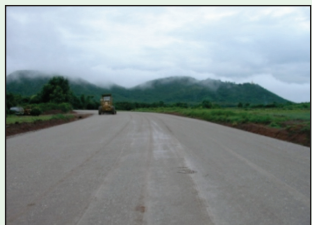
รูปที่ 4-49 พื้นทางที่แล้วเสร็จจะต้องเรียกได้ระดับและความแน่นตามข้อกำหนด
