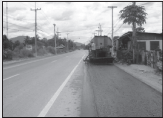
รูปที่ 6-26 การลาดยาง Tack Coat
