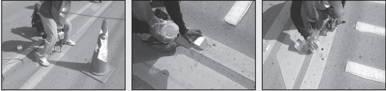
รูปที่ 7-6 รูปแสดงการติดตั้งหมุดสะท้อนแสง
