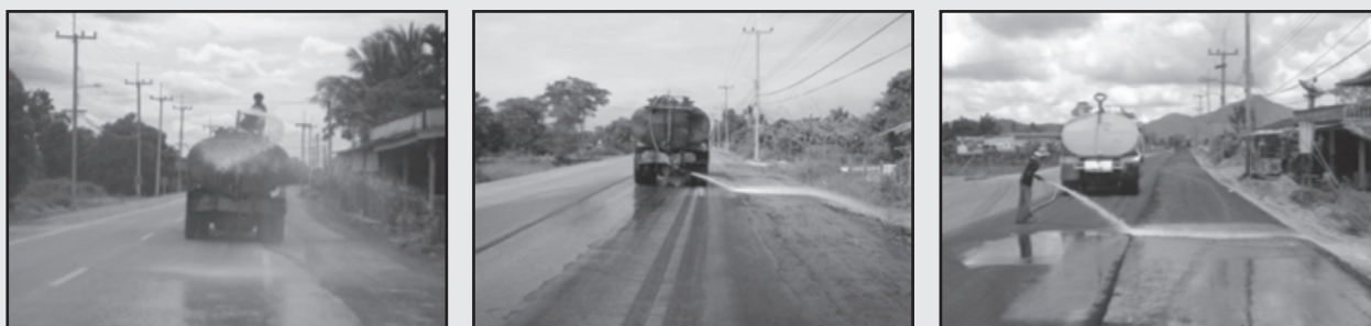
รูปที่ 6-25 ฉีดล้างทำความสะอาด ก่อนปูแอสฟัลต์
