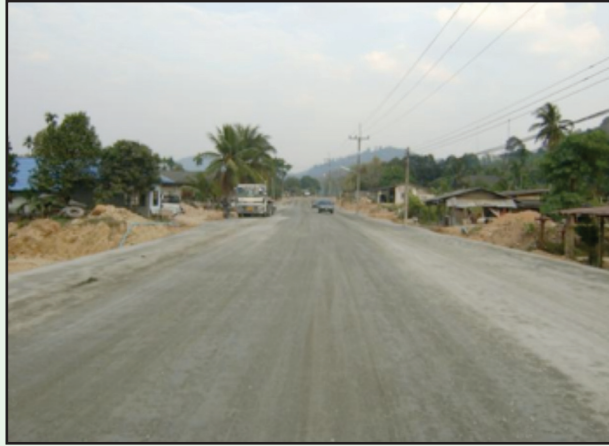
รูปที่ 4-50 ชั้นพื้นทางที่ก่อสร้างแล้วเสร็จ และยังไม่ไประมัดดินต้องฉีดพ่นน้ำหล่อเลี้ยงผิวหน้าเพื่อรักษาความชื้น
