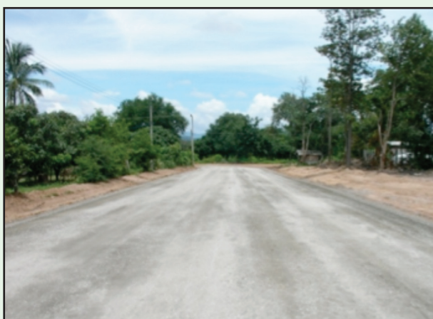
รูปที่ 4-49 พื้นทางที่แล้วเสร็จจะต้องเรียกได้ระดับและความแน่นตามข้อกำหนด
