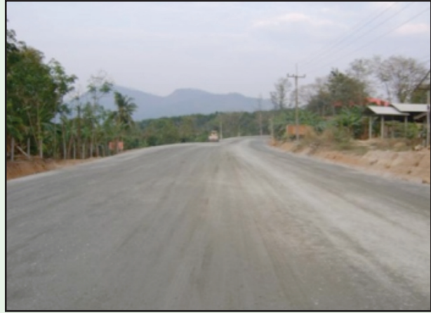
รูปที่ 4-50 ชั้นพื้นทางที่ก่อสร้างแล้วเสร็จ และยังไม่ไประมัดดินต้องฉีดพ่นน้ำหล่อเลี้ยงผิวหน้าเพื่อรักษาความชื้น
