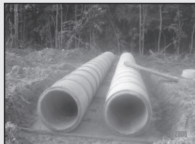
รูปที่ 5-13 ลักษณะการวางท่อ และยาแนวท่อ
