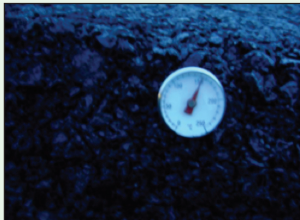
รูปที่ 6-28 ตรวจเช็คอุณหภูมิก่อนใช้งานและขณะปูลงบนพื้นทางต้องอยู่ในช่วง 120 - 150^{\circ}\text{C}
