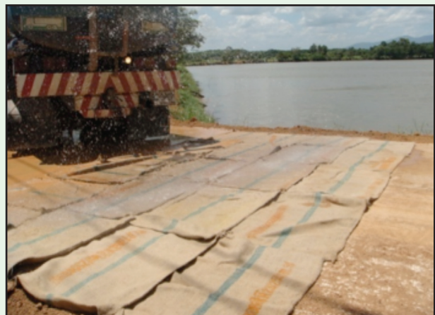
รูปที่ 6-67 การบ่มคอนกรีตด้วยกระสอบป่าน
