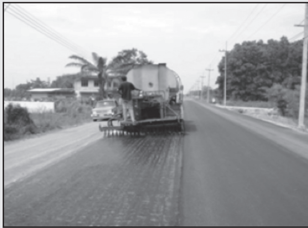
รูปที่ 6-26 การลาดยาง Tack Coat
