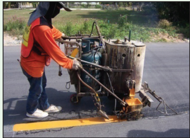
ทำการทาสีด้วยเครื่อง ที่ควบคุมอุณหภูมิได้
