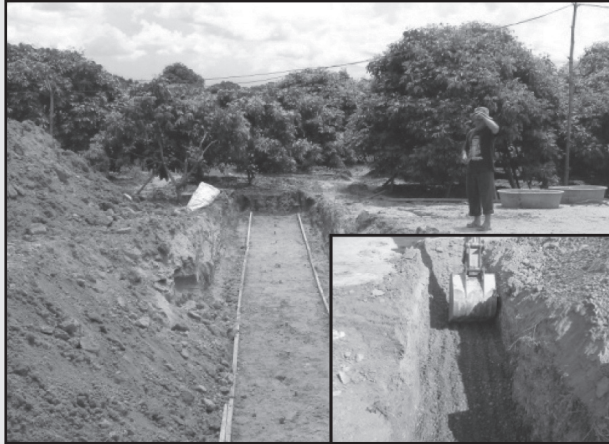
รูปที่ 5-8 ขุดร่องท่อให้ได้แนวตรง ลึกได้ระดับ
