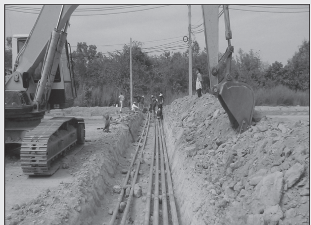
รูปที่ 2 - 1 การขุดรื้อย้ายสาธารณสุขปโภค
