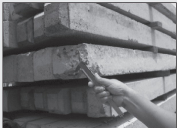
ตรวจสอบเหล็กเสริม
