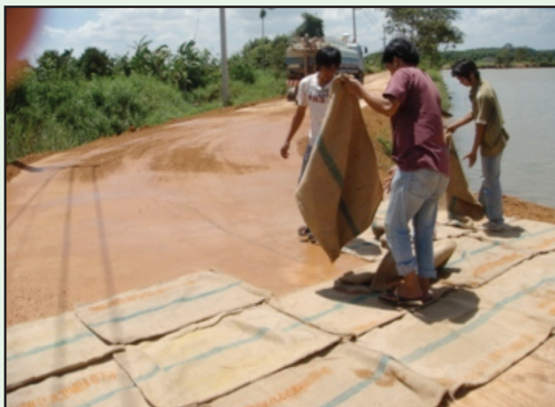
รูปที่ 6-67 การบ่มคอนกรีตด้วยกระสอบป่าน
