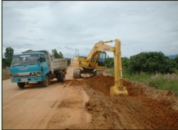
รูปที่ 4-17 การขุดวัสดุที่ไม่เหมาะสมออกในบริเวณ Soft Spot
