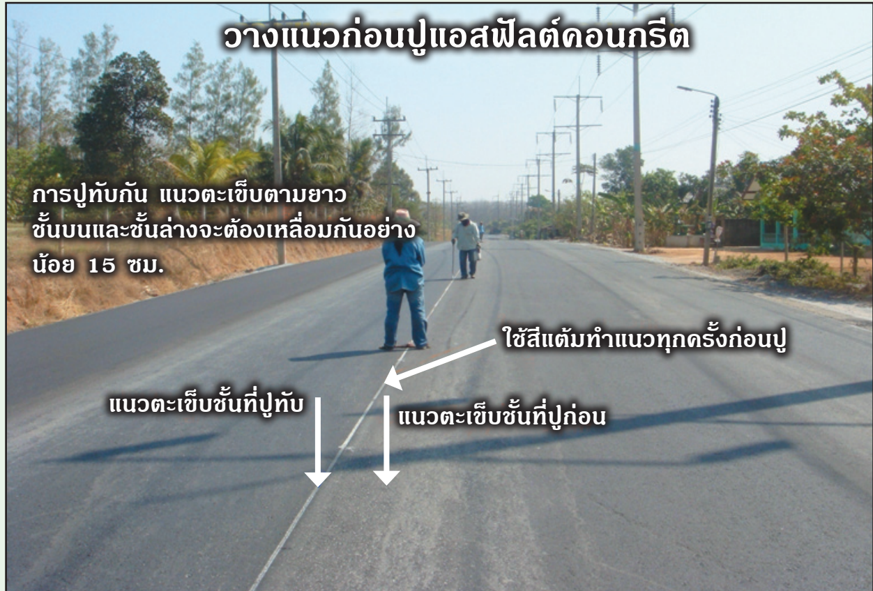
รูปที่ 6-29 แสดงการวางแนวเกลี่ยปูแอสฟัลต์คอนกรีตชั้นถัดไป
