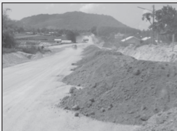
รูปที่ 4-37 กองวัสดุรองพื้นทางบนคันทางหรือชั้นวัสดุคัดเลือก
