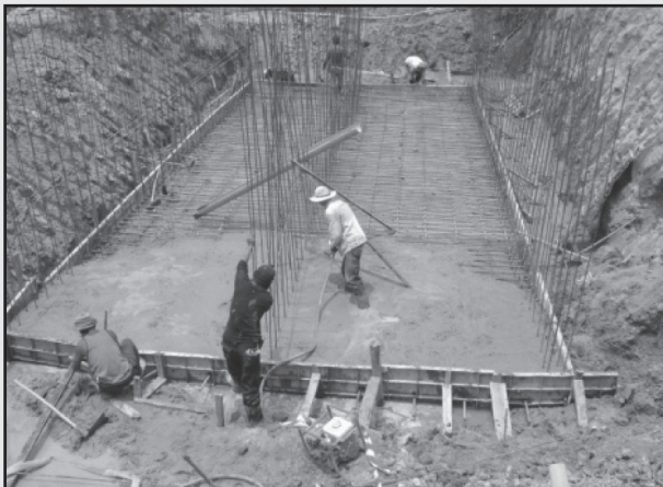
รูปที่ 5-28 (ก) การจี้คอนกรีตขณะเทคอนกรีต
