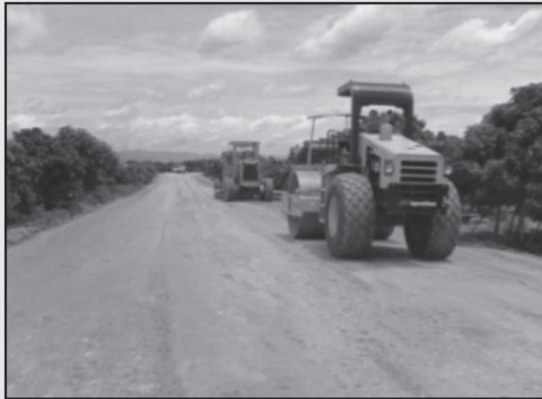
รูปที่ 4-33 การบดอัดใหม่ (Recompaction) เพื่อให้ได้ความแน่นตามเกณฑ์มาตรฐาน
