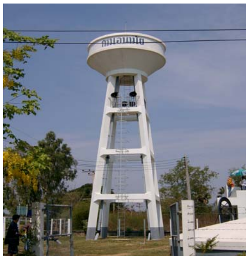
รูปที่ 22 หอถังสูง
