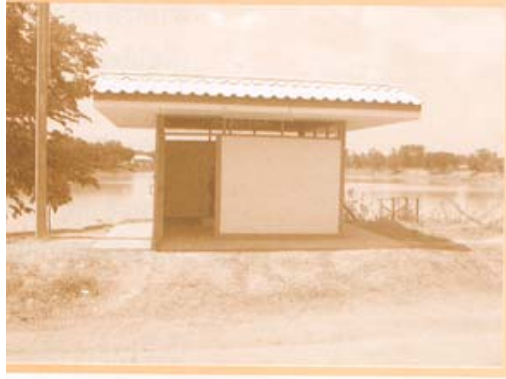
รูปที่ 33 เครื่องสูบน้ำคืบติดตั้งในโรงสูบน้ำ
